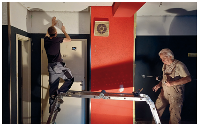
Rico und Stefan Romey (von links) bei der Renovierung. Die ehemalige Kneipe in der Bahnhofstraße 1 muss gespachtelt und gestrichen werden. Foto: Sternitzke, Gerhard
